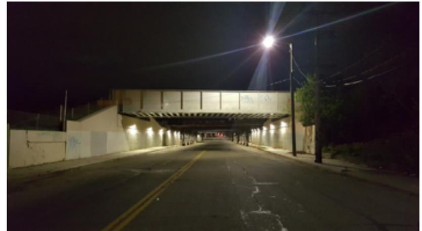
**Este viaducto, uno de los muchos cruces en la calle Junction, es un buen modelo para las mejoras en otros viaductos: áreas lateral y central bien iluminadas, muros de carga estables y limpios y drenaje funcional. La mayoría de los otros viaductos tienen múltiples vigas de soporte entre sus empalmes, lo que requiere luces adicionales para lograr niveles de iluminación consistentes.**
